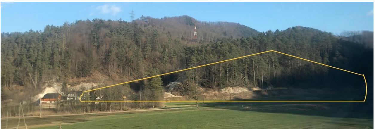
Slika 3: pogled na obravnavano območje iz zahodne strani (vir: foto arhiv Ketera d.o.o.).
