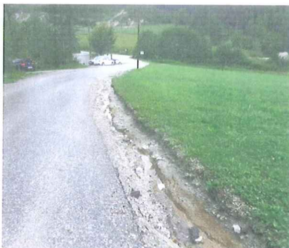
Kanali globine 30-40 cm na mestu bankine ob LC 426113 (Stranje – Kopačija - Mala Kostrevnica) nad Rekonovim pruhom
