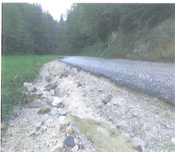
Kanali globine 30-40 cm na mestu bankine ob LC 426113 (Stranje – Kopačija - Mala Kostrevnica) nad Rekonovim pruhom
