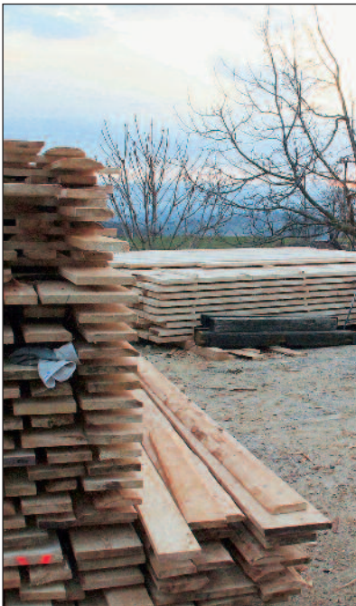
Nažagan les so sproti zlagali in čaka pripravljen na izdelavo ostrešja.
