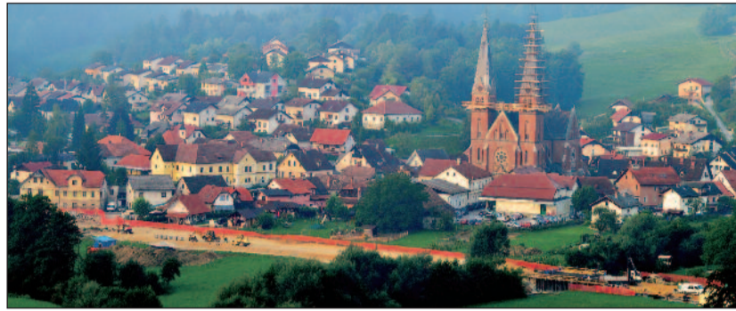
Obnoveitev starega in izgradnja novega
