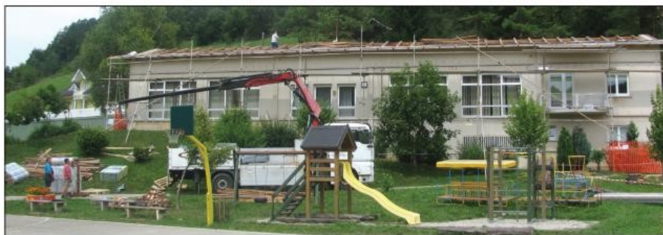
Prenova strehe PŠ Velika Kostrevnica
