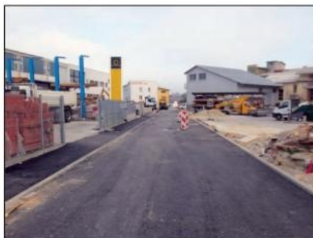
Gradnja komunalne infrastrukture na območju bivše IUUV
