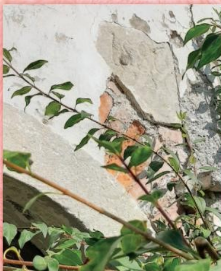
Nad vhodnim portalom na začetni strani vrezana letnica 1586 (foto: Jernej Kotar)
