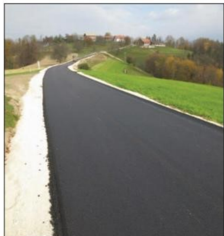
Asfalt v Jastrebniku
